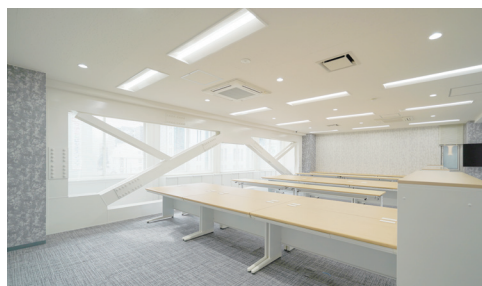
耐震補強を施した明るく広々とした執務室
